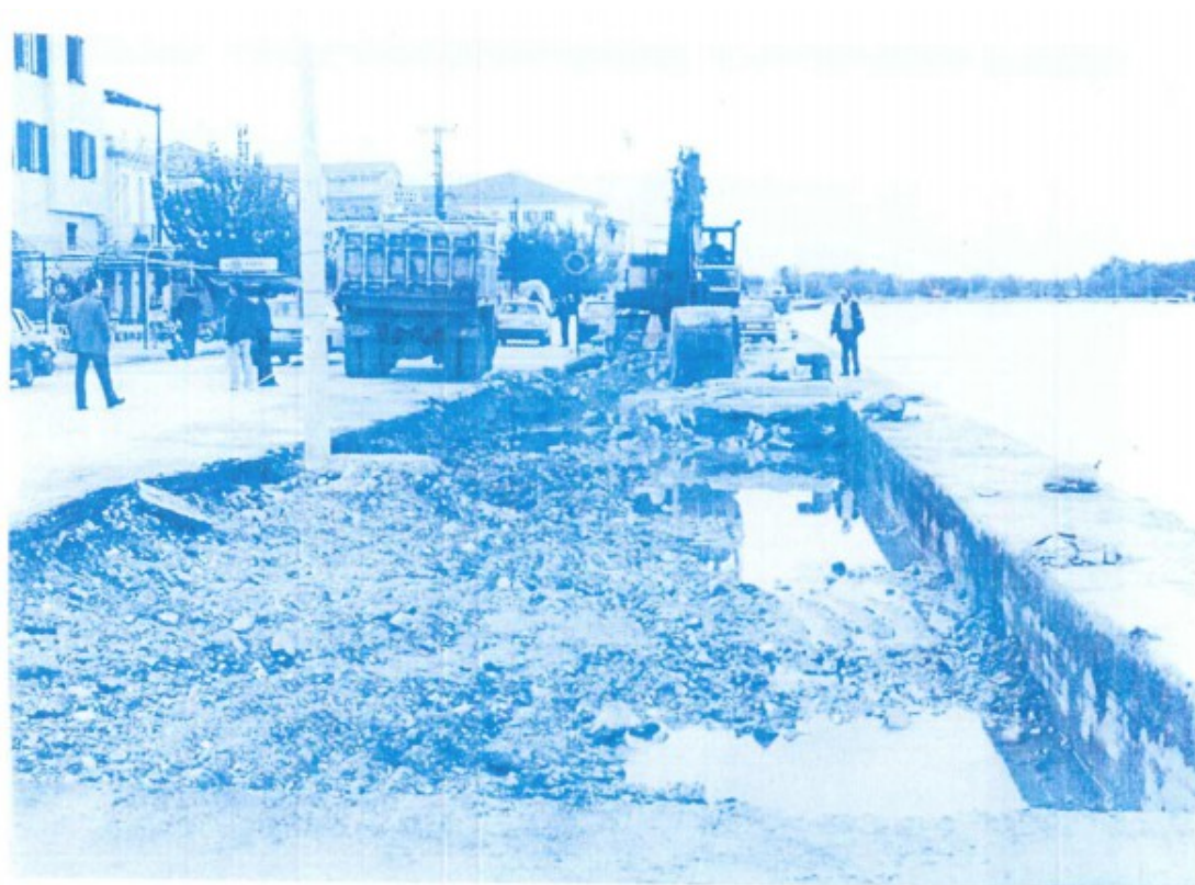
Φωτ. 6: Εργασίες επισκευής ανωδομής παραλιακού κρηπιδώματος έτους 1988
