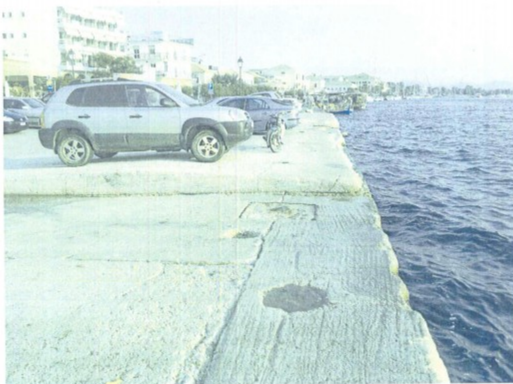
Φωτ. 2,3: Ανωδομή γωνιακού κρηπιδώματος με πολύ χαμηλή στάθμη από Μ.Σ.Θ.
