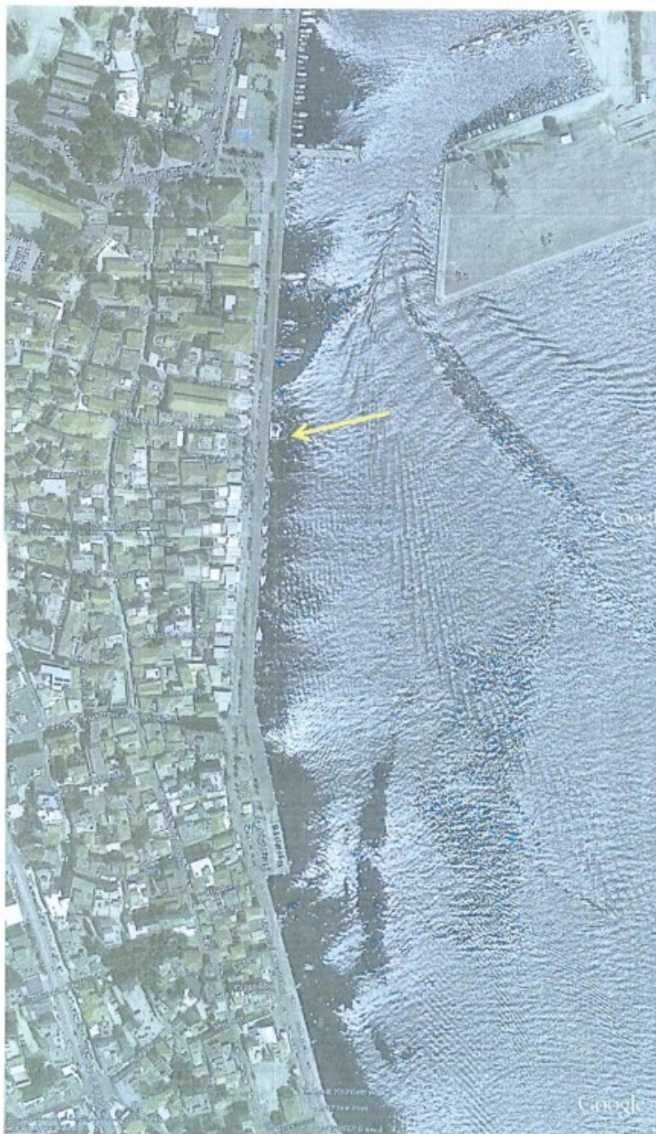
Φωτ. 1: Περιοχή επιθεώρησης στα παραλιακά κρηπιδώματα της Πρέβεζας
